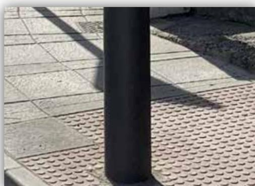
Instalación sin placa base, mediante **empotramiento.**
