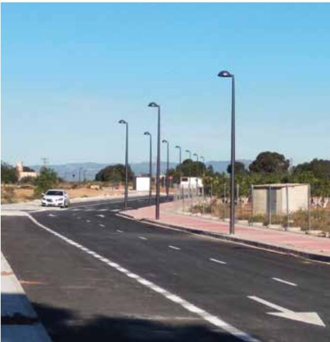
Farolas de seis metros. La **seguridad pasiva** convierte a las columnas de PRFV en una excelente opción para columnas de iluminación vial.
