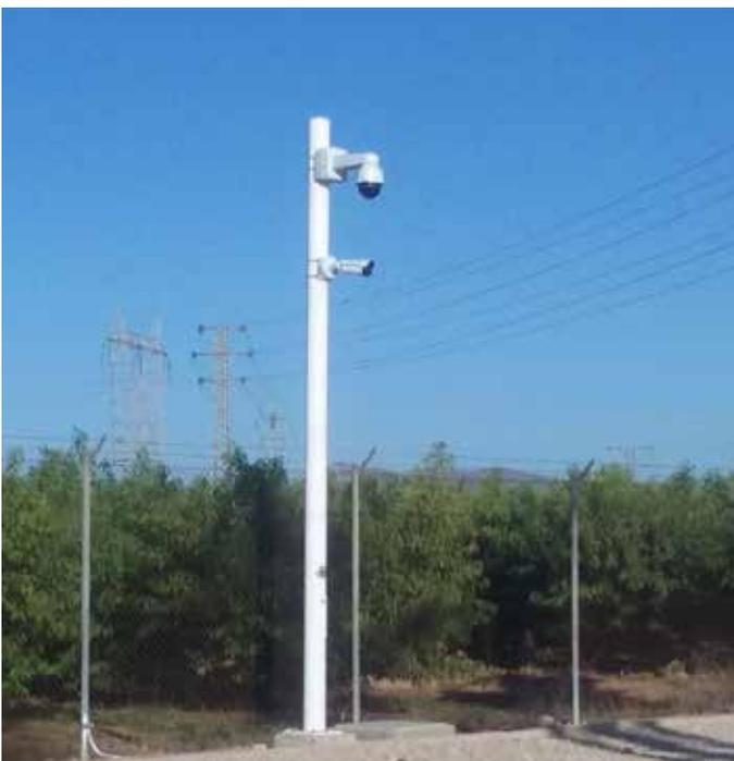
**Columna** para instalación de **cámaras de seguridad y vigilancia**. La deformación en punta es muy pequeña, lo que permite la instalación de equipos de precisión.
